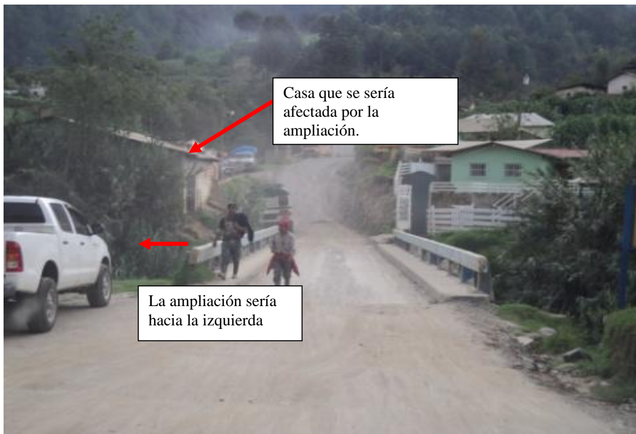
FOTO No 2: La fotografía muestra el puente EL MEMBRILLO, en la estación 0+600, y además muestra hacia donde debe de ser la ampliación del puente. A la fecha no se tiene ninguna resolución acerca de los puentes, por lo tanto si se iniciara la construcción de lo pendiente en este tramo la sección típica quedaría estrangulada en estos puntos.
