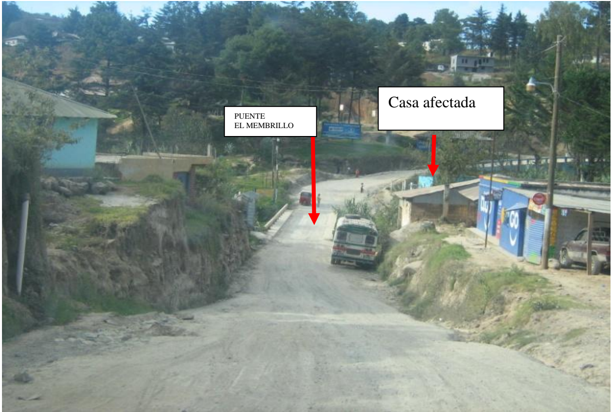
FOTO No 1: La fotografía muestra el puente EL MEMBRILLO en la estación 0+650, en la salida de Comitancillo hacia San Lorenzo. La sección típica del puente no es la misma que la sección típica de la carretera por esa razón se debe ampliar el puente en esta vista hacia la Derecha. Hasta la fecha no se tiene ningún pronunciamiento del Banco al que se le hizo la consulta en una de sus visitas con relación a la ampliación de los puentes.
